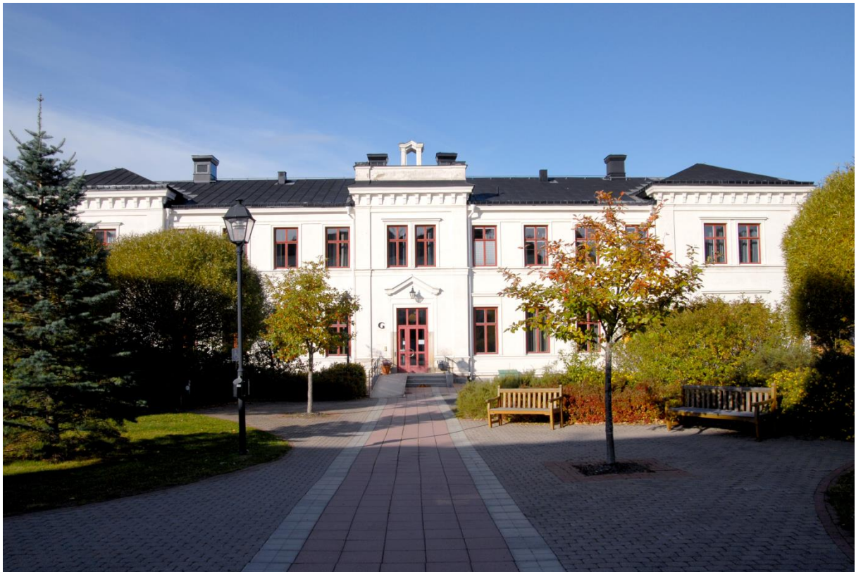
Hus Smaragden campus Härnösand Foto: Åke Johansson
