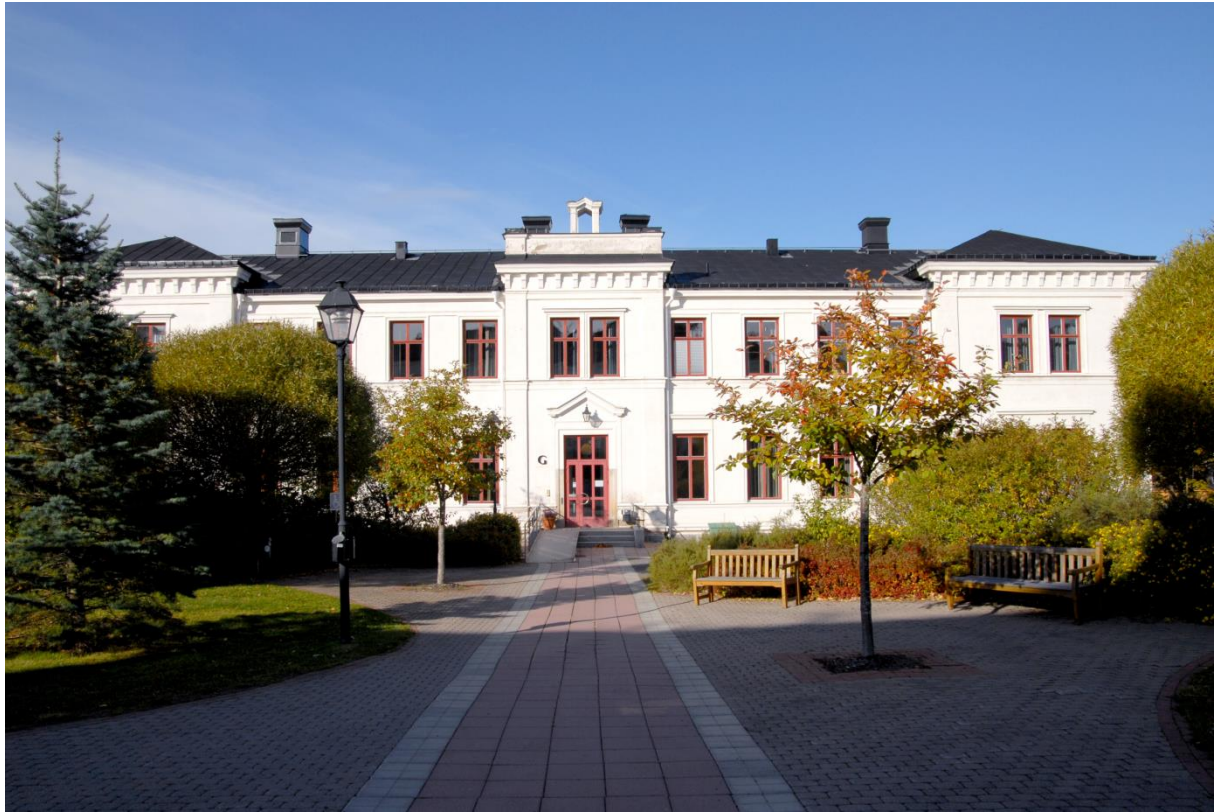
Hus Smaragden campus Härnösand Foto: Åke Johansson
