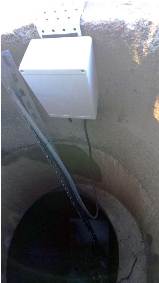
Sensorn kommunicerar mätdata trådlöst till en IoT-plattform med websida som larmar vid förekomst av olja.
